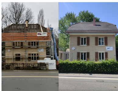
Altes Dach - neues Dach
